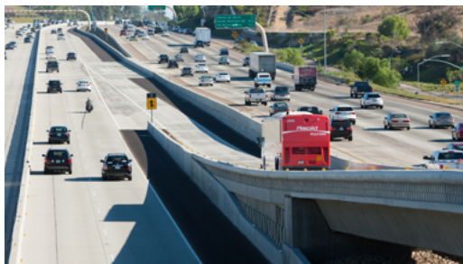
Direct Access Ramp (DAR) (Rampa de Acceso Directo) Una entrada de carretera especial por la que autobuses, vehículos compartidos o personas que pagan peaje pueden ingresar a carriles expresos sin tener que incorporarse desde el lado derecho.
