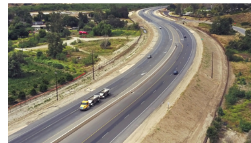
Shoulder Widening (Ampliación del Lado de la Carretera) Proyecto que amplía el pavimento por la orilla de una autopista por seguridad en caso de emergencias.
