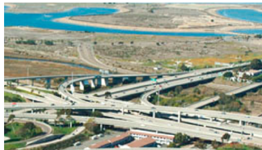
Connector (Conector) Una rampa que conecta una carretera con otra.
